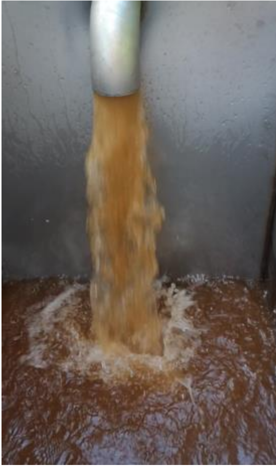
Durante el proceso de limpieza Air Scouring (Fundición gris).
